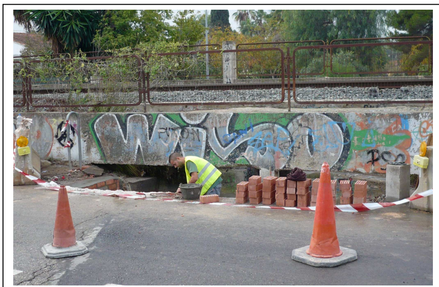
Obres realitzades després de les pluges
