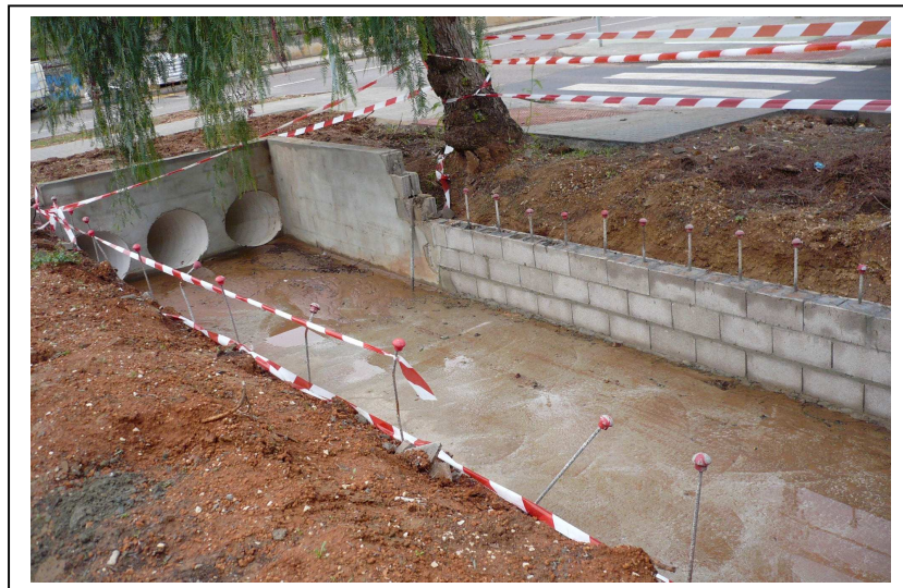
Reposició dels murs de la canalització
