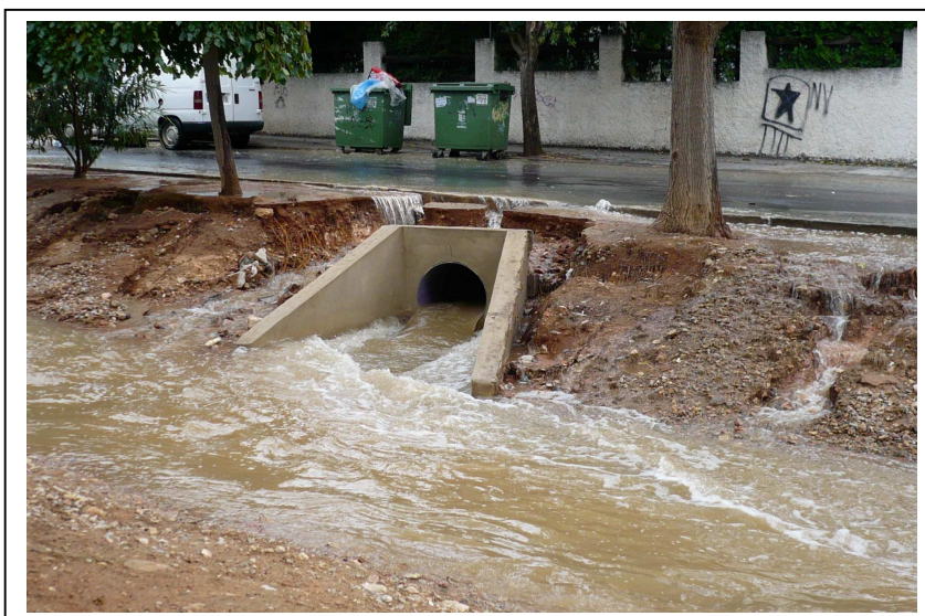
Colector 299-293 en el punt de conexió al barranc
