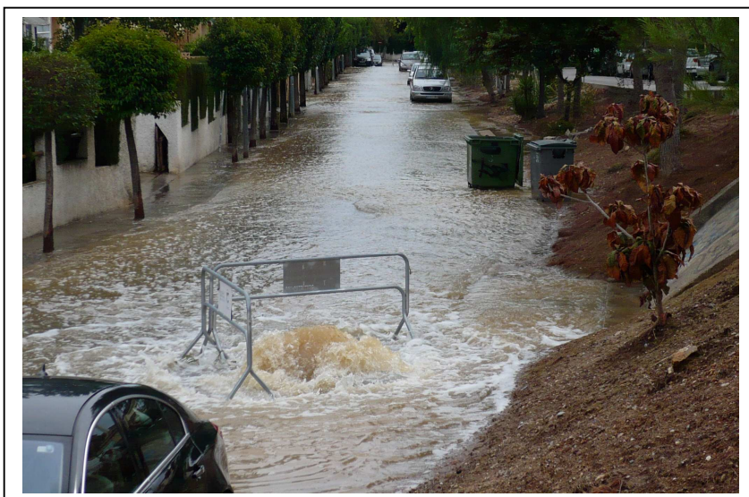
Carrer 232 amb el col·lector sobrecarregat. Dissabte 29 de matí
