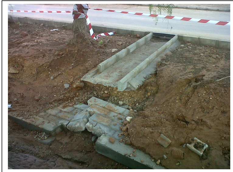
Murs destrossats per la pluja
